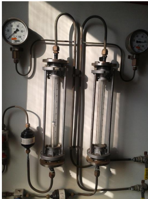
Слика бр. 6 Инсталација за снабдевање и контролу протока ваздуха и пропана
